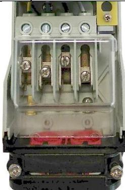
Erdanschluss herstellen und PEL-S im Mast einbauen
